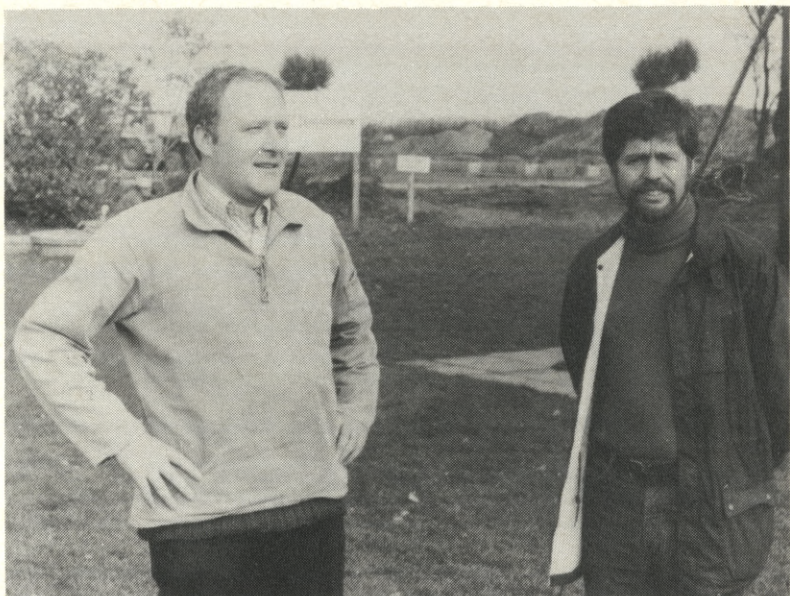
To af fadderne og initiativtagerne til opførelsen af Hagedstedhallen, Anders Nielsen tv. og Per Rasmussen. I baggrunden er man i gang med at opføre hallen.
